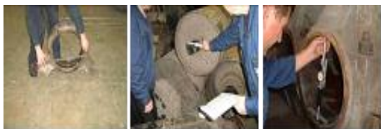
Figura 4. Kontrolli i përmasave të detaleve para se të fillojë riparimi
