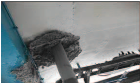
Figura 5. Korrozioni i betonit dhe armaturës
