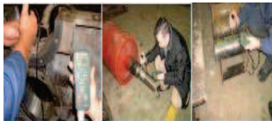
Figura 6. Matja e fortësisë së detaleve të ndryshme para riparimit me aparatën MIC 10
